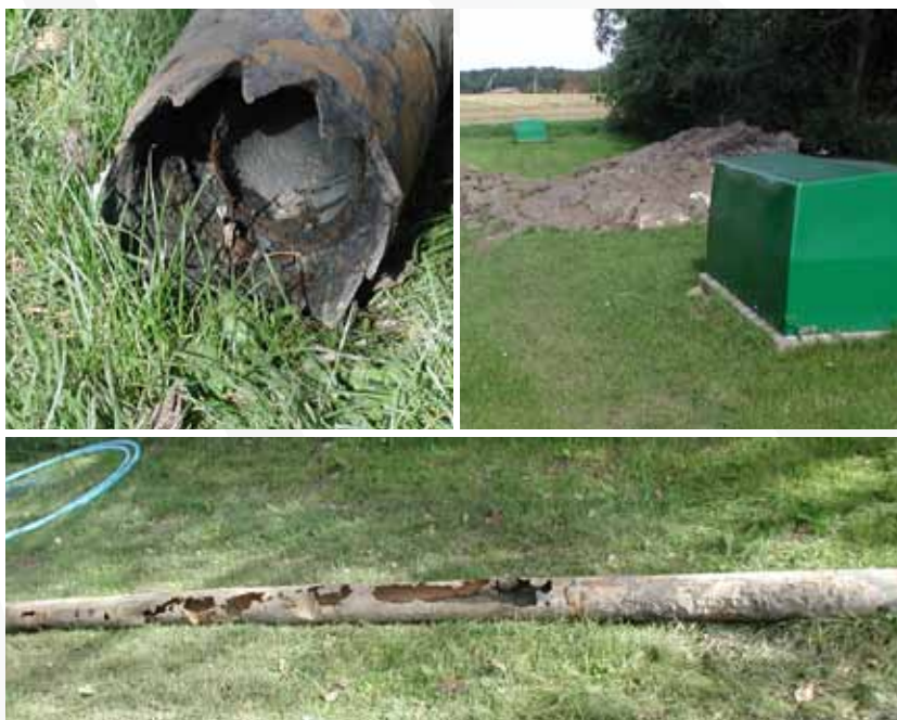
Gammelt forerør og overgang til filter fjernet fra boring.
